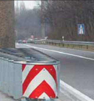
Der Anpralldämpfer rettet an Autobahnabzweigungen Leben. Fotos: Gast
