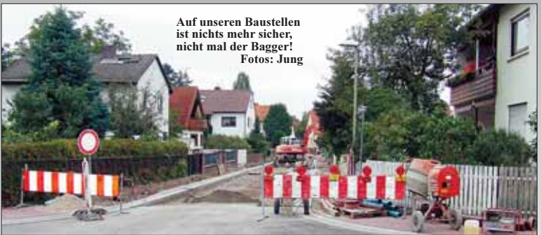
Fertig zum Abtransport: Baustellen werden bei uns zu Selbstbedienungsläden.
